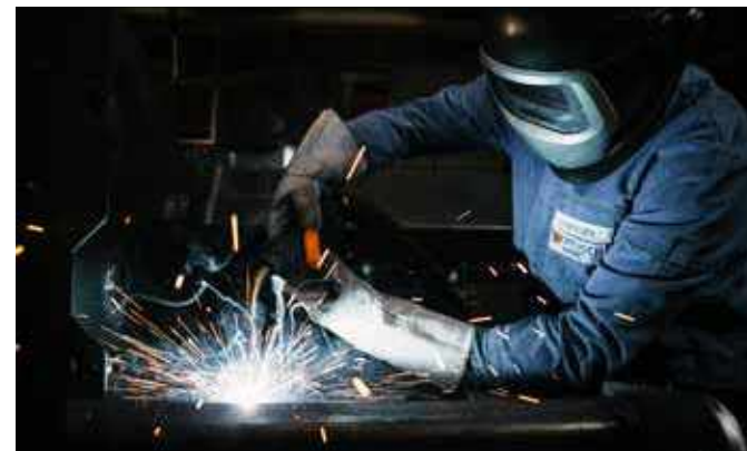
Langjährige, DIN-geprüfte Schweißer sorgen täglich für höchste Qualität der Schweißkonstruktionen.
